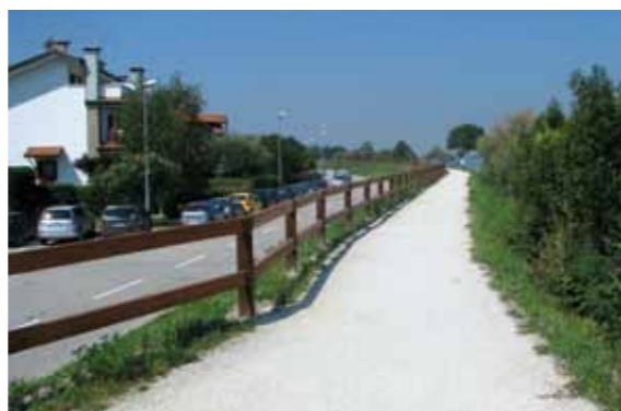
Uno scorcio dell'argine della laguna dove avrebbe dovuto passare la translagunare
